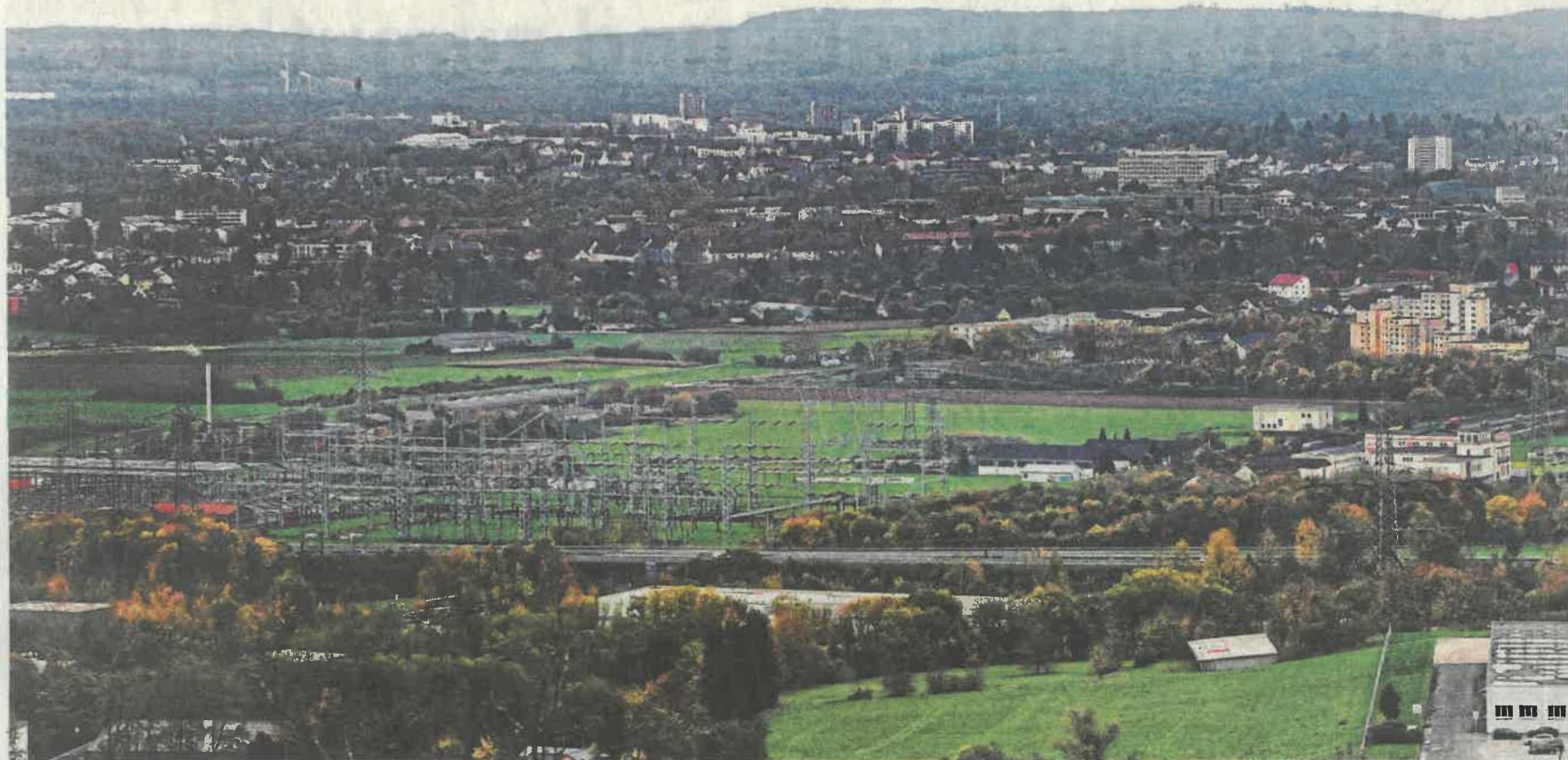
Die Grünfläche zwischen Umspannwerk und der Weststadt: Das ist das Katzenfeld, auf dem ein großes Rechenzentrum und weitere IT-Firmen angesiedelt werden sollen.
